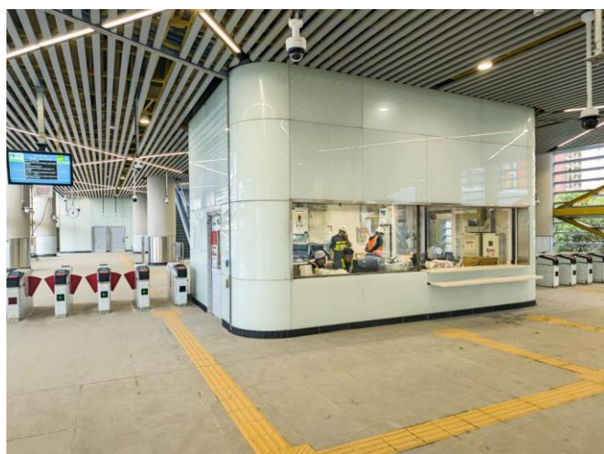
圖 4 路氹蓮花圓形地轉車站 - 進行內部裝修
