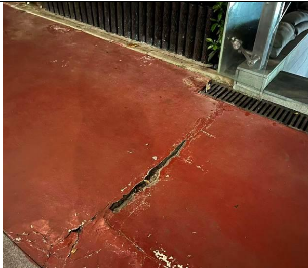
圖一、二：中央公園外圍跑道部分位置有崩損凹陷，容易積水加速耗損老化
