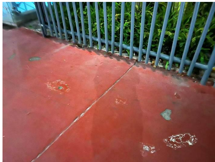
圖一、二：中央公園外圍跑道部分位置有崩損凹陷，容易積水加速耗損老化
