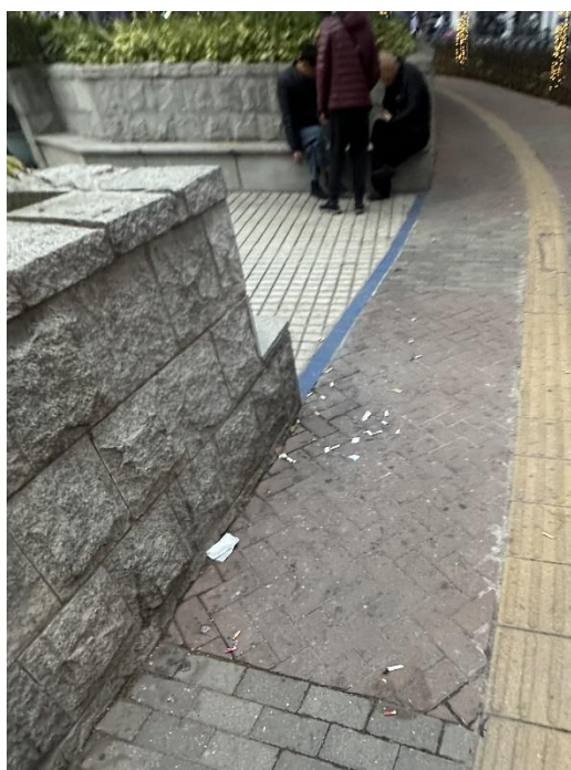
祐漢公園禁煙藍線外有大量“煙頭”丟棄於行人路上（攝於 2 月 1 日下午）
