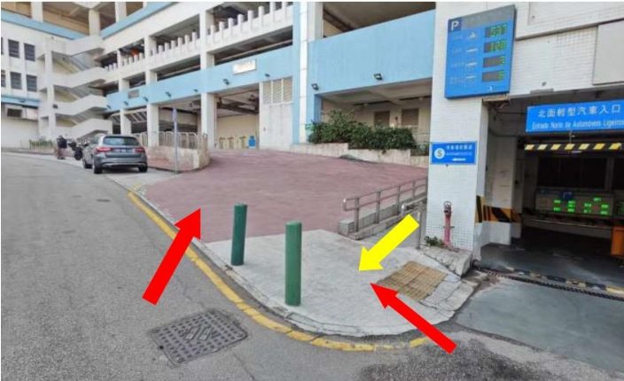
圖一 不少電單車穿越行人道到緊急車道 (圖片由居民提供)
