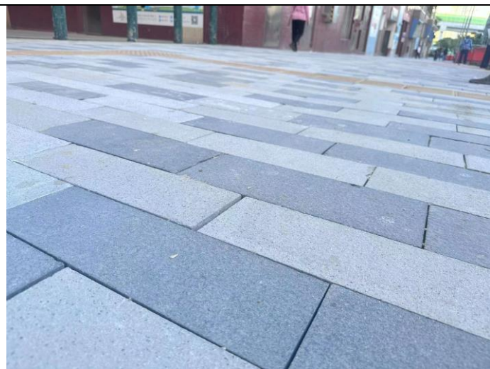
(圖一) 新鋪的地磚存在高低不平的狀況
