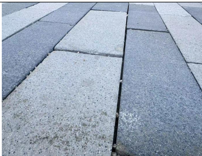
(圖二) 新鋪的地磚存在高低不平的狀況
