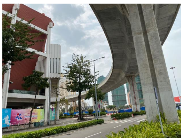
奧林匹克游泳館圓形地周邊路網重整工程 已恢復施工 2020年3月3日攝
