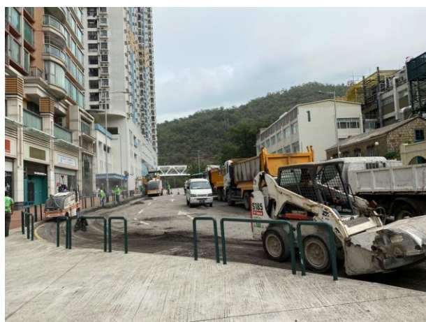
湖畔大廈對出外進行路面重鋪工程 2020年3月3日攝
