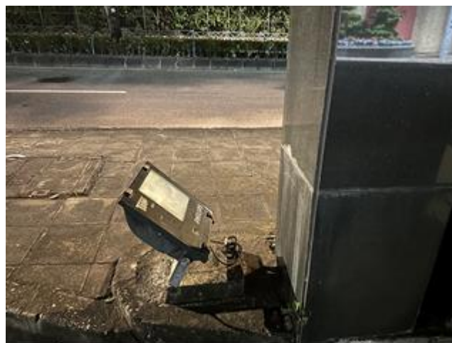
圖四：沘仔運動場迴旋處下的燈具 鋪滿蜘蛛網及灰塵
