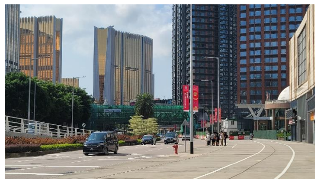
圖二 路氹東側蓮花海濱大馬路行人天橋建設中
