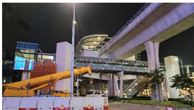
圖一 路氹東側體育館大馬路行人天橋建設中
