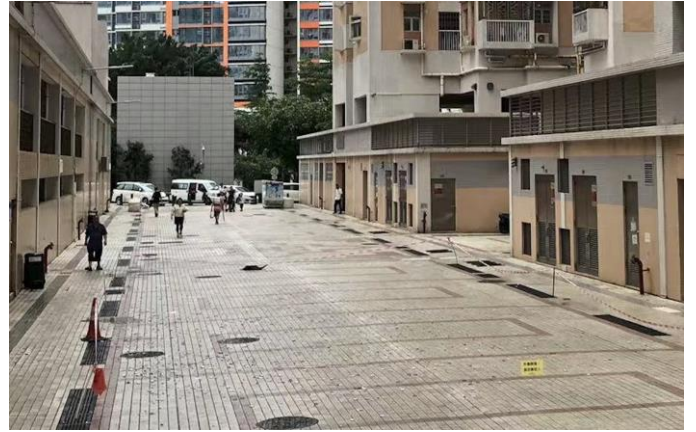
居雅大廈外牆剝落，碎片散滿一地 （照片由市民提供）
