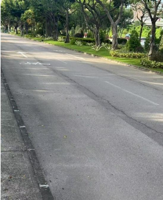
圖一. 西堤馬路後半段的地線顏色褪色，路面亦有不平整情況。
