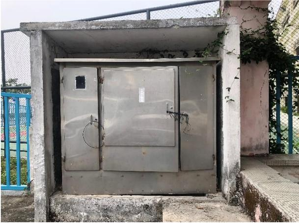
電箱蓋的門鎖已破損，以至蓋門未能完全合上
