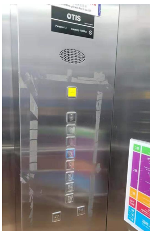
第三個出口及電梯樓層按鍵情況
