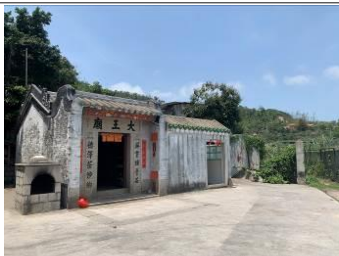
大王廟前地欠衛生設施
