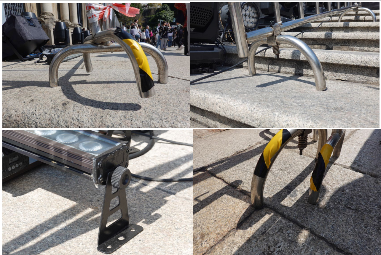
圖四：大部份鐵圍欄和金屬燈架腳皆沒有膠墊作緩衝
