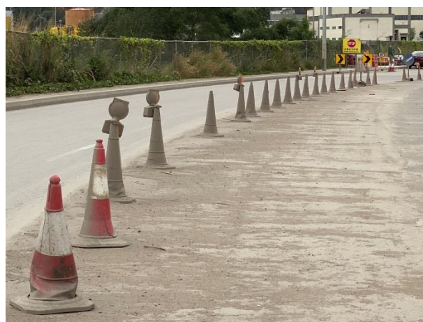
九澳隧道工程周邊道路雪糕筒已佈滿了灰塵
