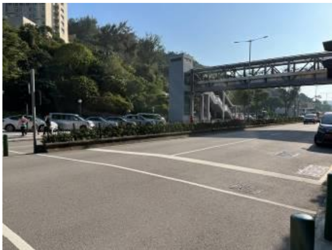
圖 6 位於石排灣馬路近石排灣郊野公園行人天橋
