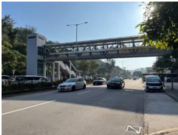
圖 7 位於石排灣馬路近石排灣郊野公園行人天橋
