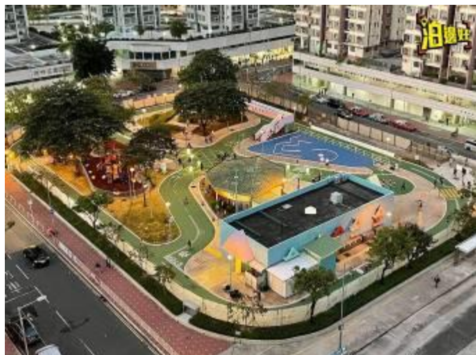
圖 1 香港沙田交通安全公園全景
