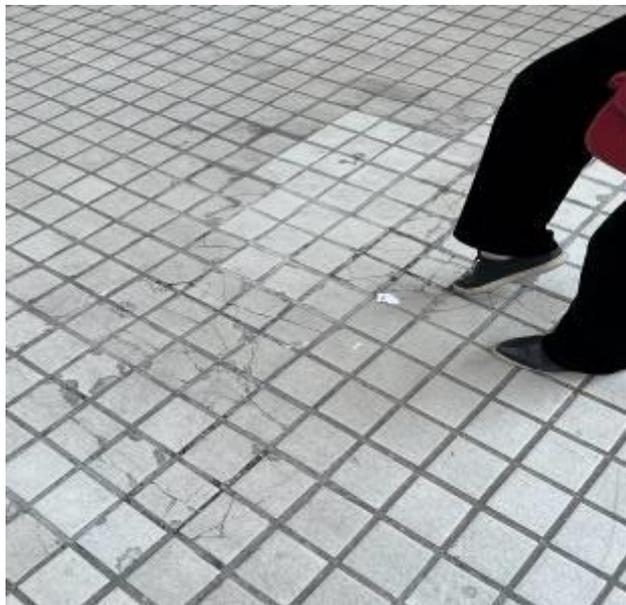
(圖七): 業興大廈第二街及第三街的平台入口處的小斜坡用街磚鋪砌，部份街磚已受損壞。
