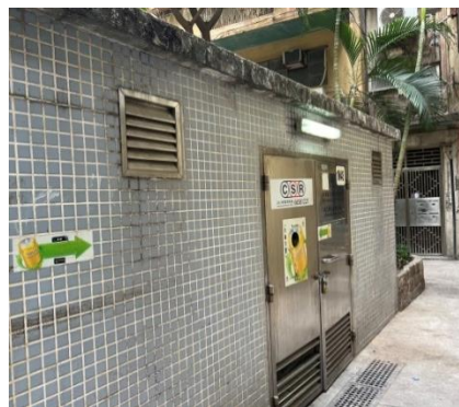
圖 2. 垃圾房通風處縫隙及電池回收口較大
