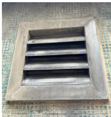
圖 2. 垃圾房通風處縫隙及電池回收口較大
