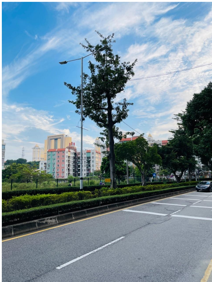
部分路燈容易被樹蔭遮擋
