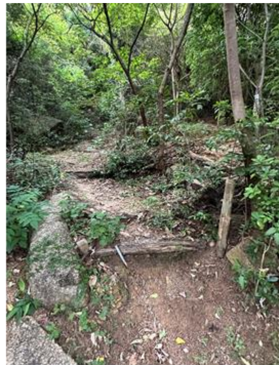
圖四：步行經的梯級現時使用木條使路面凹凸不平
