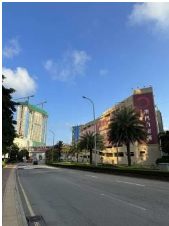
圖 4 該路段缺乏行人過路設施
