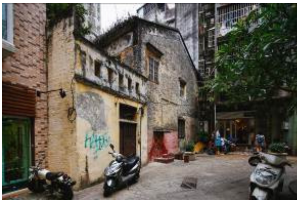
圖 3 - 龍安圍 6 號 (已被拆卸)
