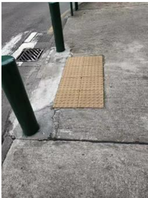
圖五 即時用了圖二的導盲磚，因下降路緣有坡道 亦因此跌倒 位置：花城附近
