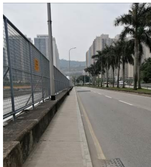
建議在該路段加設護欄
