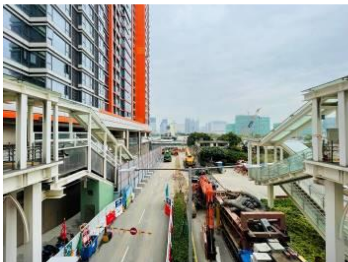
石排灣線工程靠近民居
