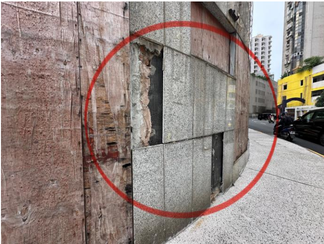
圖五：牆身剝落
