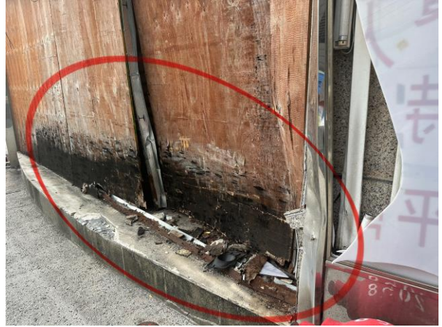
圖四：被雨水侵蝕導致發霉
