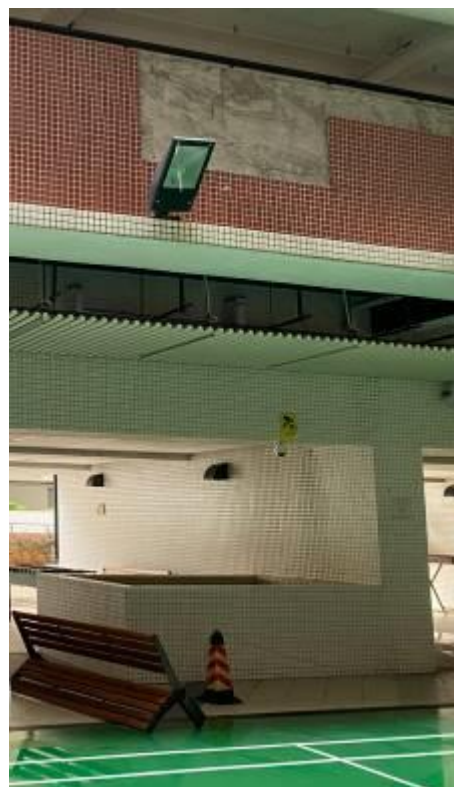
圖四 球場上方瓷磚剝落
