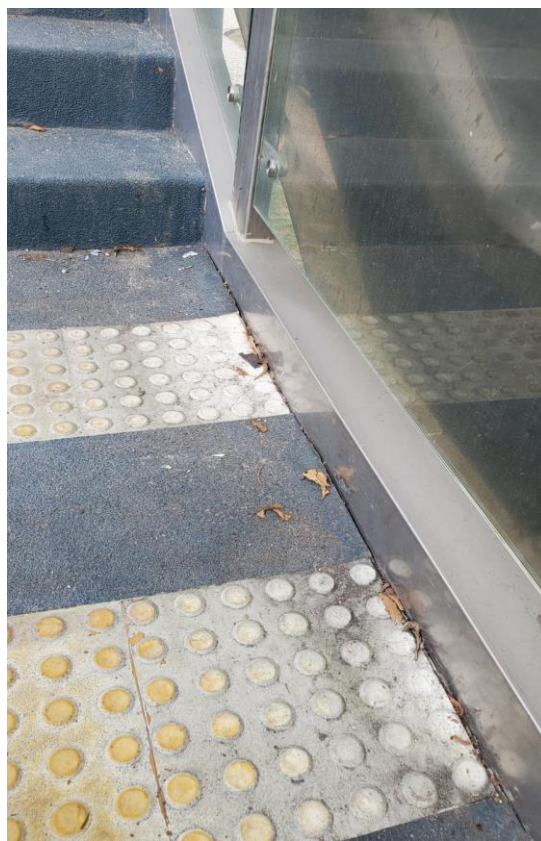
圖二：行人天橋樓梯的地膠出現高低不平的狀況
