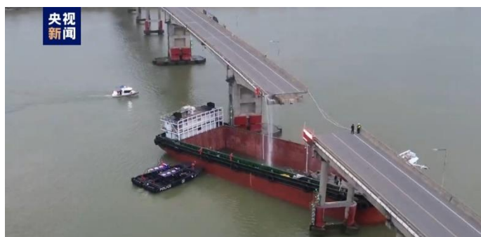
圖一 2024 年 2 月 22 日廣州南沙貨船撞橋
