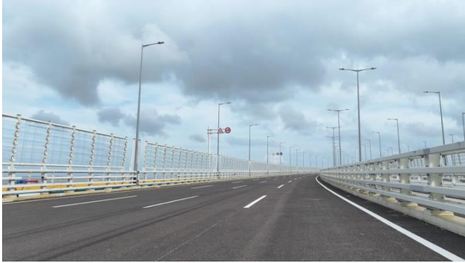
圖 3 大橋主線橋行車線
