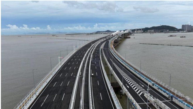
圖 2 橋面完成瀝青鋪裝
