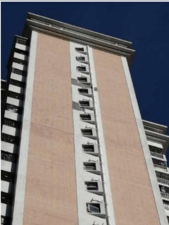
居雅大廈出現了大大小小不同面積的外牆剝落，情況令人擔憂
