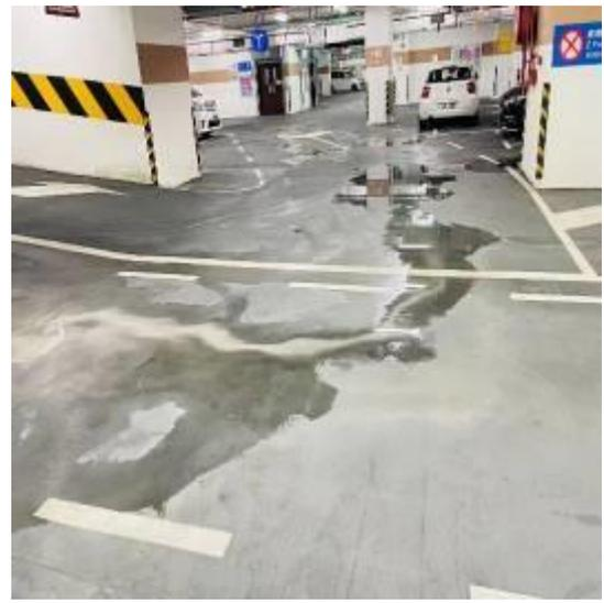
(圖二) 漏水流出地面
