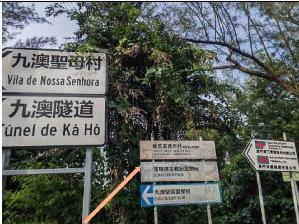
圖 1 路牌經過長時間使用已出現破損及褪色
