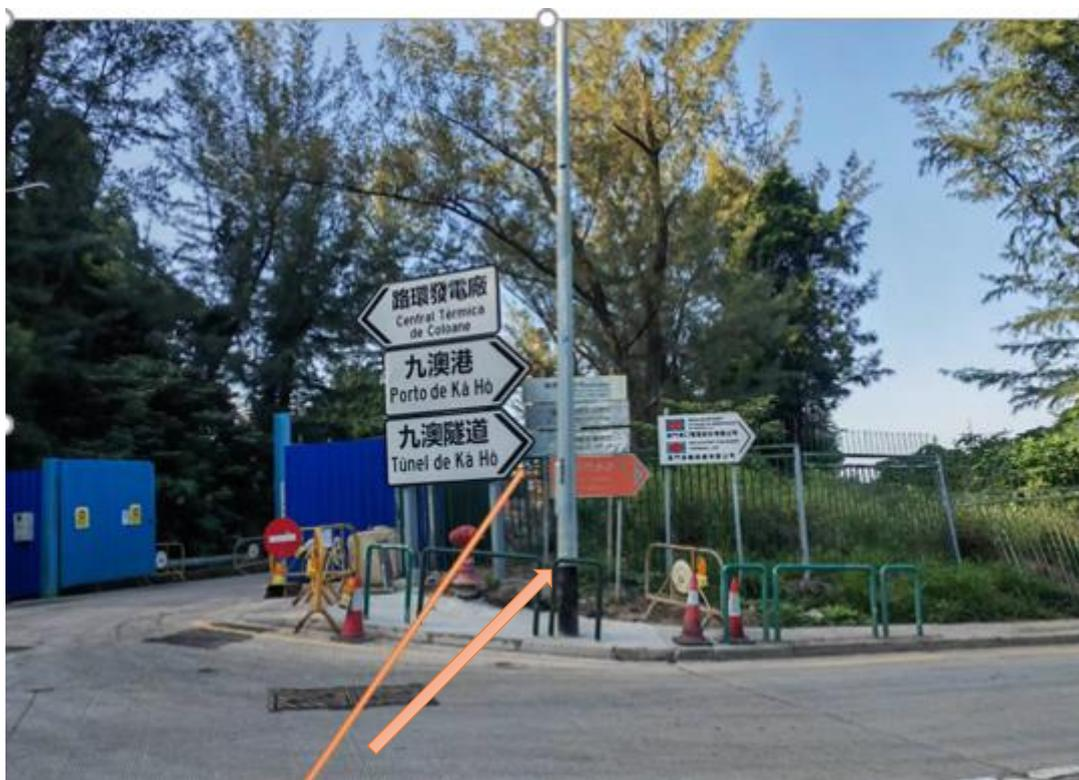
圖 2 原有的路牌被新建造的路牌遮掩 / 破損及褪色
