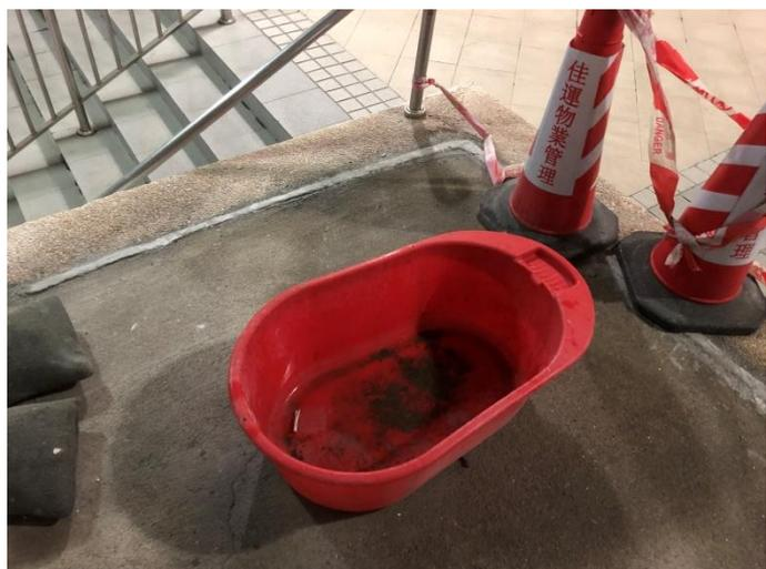
圖 9 在樓梯邊緣鋪上防水膠防止漏水
