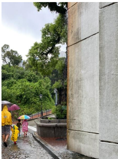
嘉模泳池牆身坑紋設計，令雨水射向行人道 2020 年 8 月 2 日攝
