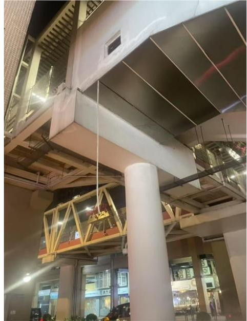
圖二 氹仔空中走廊近濠景的落腳點，天橋有物件剝落，搖搖欲墮。
