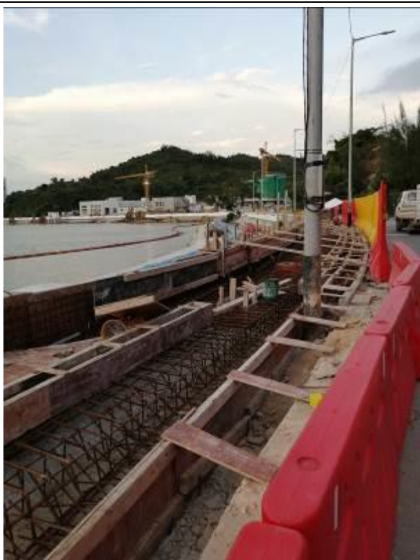
石排灣水庫康體休憩區仍在施工中
