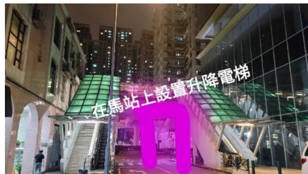
圖四 延伸行人天橋設置升降電梯
