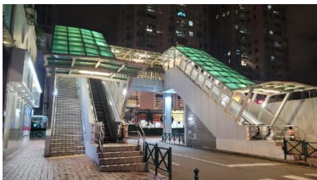
圖三 外在因素(地下空間不足、欠缺地面空間)制約設置升降電梯
